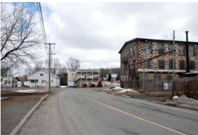
45. Vue d'ensemble de la rue Saint-Jean, à l'approche de l'intersection formée par les rues Stanley et Saint-Joseph.
