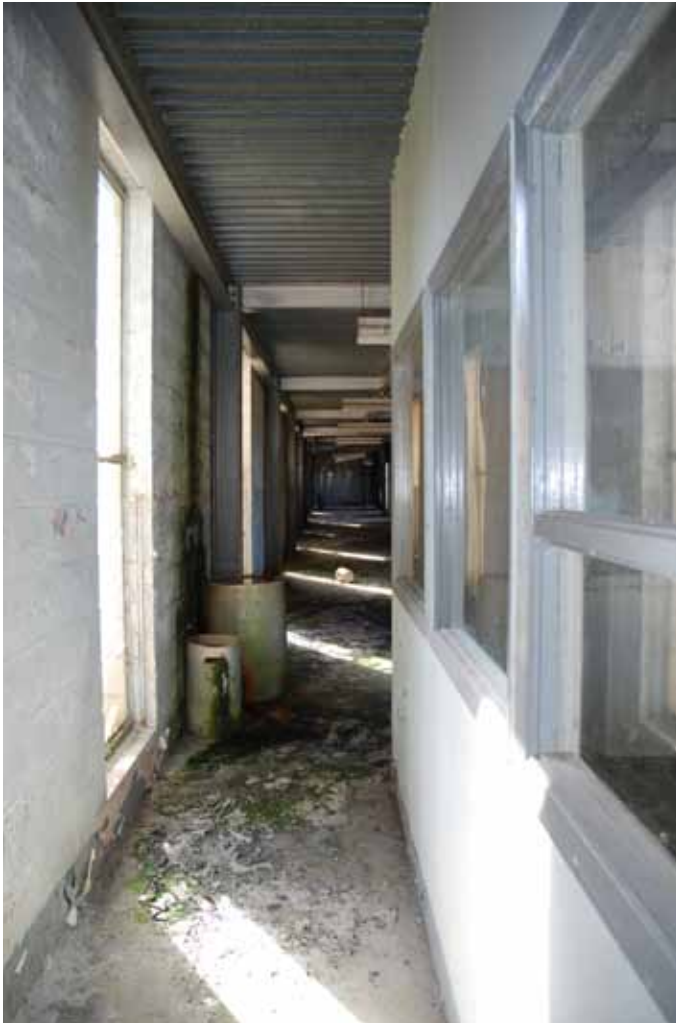
21. Corridor reliant l'entrée principale au bâtiment n° 1, à l'étage supérieur. À noter l'espace réservé pour les bureaux de la direction (droite), aménagés dans les années 1965. Photo : Chantal Lefebvre, SHHY, octobre 2011.
