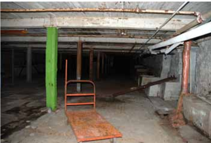
27. Vue partielle du soubassement, à la jonction des bâtiments n° 1 et 14. À remarquer la transition entre les piliers de bois du bâtiment n° 1 (avant-plan) et les colonnes d'acier du bâtiment n° 14 (arrière-plan). Photo : SHHY, octobre 2011.
