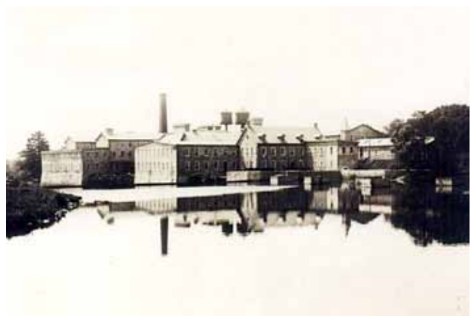
34. Installations industrielles de Lachute Mills, date indéterminée. Source : © BAnQ, CP 12900 CON.
