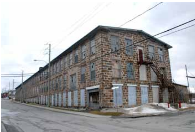
8. Façades latérale droite et arrière des bâtiments nos 1 et 14. L'ancienne usine surplombe l'intersection formée par les rues Stanley et Saint-Jean.
