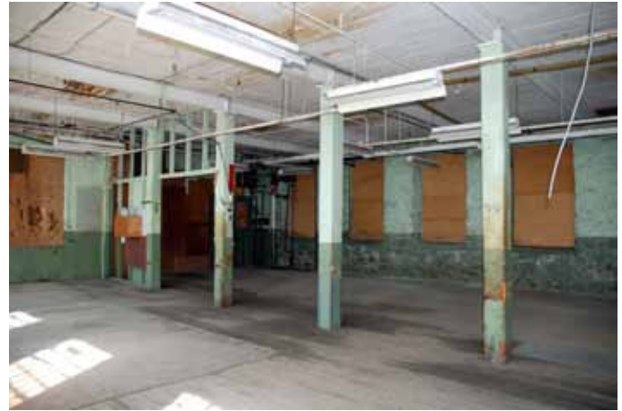
29. Bâtiment n° 2, au rez-de-chaussée. Photo : SHHY, octobre 2011.
