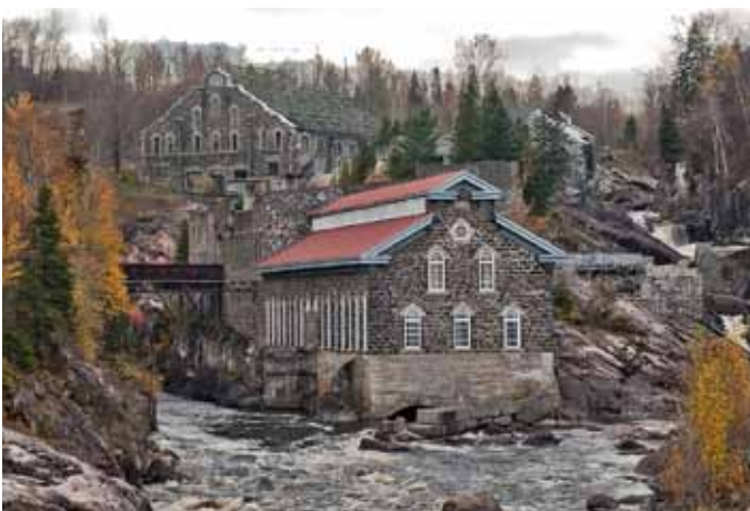
37. Pulperie de Chicoutimi sur la rivière Chicoutimi. Le moulin à l'avant-plan est érigé en 1903, alors que le bâtiment de l'atelier de réparations mécaniques en arrière-plan est construit en 1921. Source : « Pulperie de Chicoutimi ». Wikipédia . [en ligne] : http://commons.wikimedia.org/wiki/File:Pulperie_de_Chicoutimi.jpg
