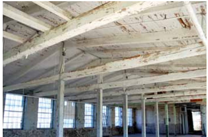
30. Détail de l'armature de bois soutenant la toiture, observable dans le bâtiment n° 2, à l'étage supérieur. Photo : SHHY, octobre 2011.
