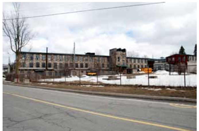
11. Façade latérale droite des bâtiments nos 1 et 14. La façade arrière du bâtiment n° 2 est visible à la droite de la photographie, de même qu'une partie du site enclavé par les bâtiments industriels et la rivière.
