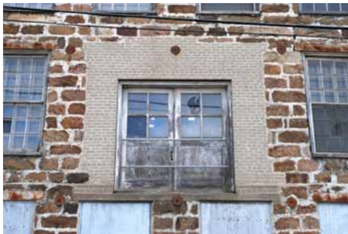
17. Débarcadère aménagé ultérieurement dans la façade latérale droite du bâtiment n° 14, au niveau du rez-de-chaussée.
