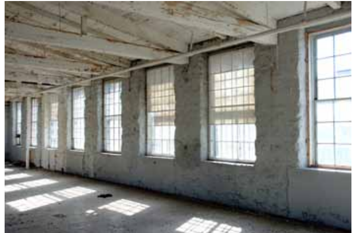
31. Alignement de vastes fenêtres destinées à favoriser l'apport de luminosité à l'intérieur de l'enceinte et ventiler les aires de travail. Bâtiment n° 2, étage supérieur. Photo : SHHY, octobre 2011.
