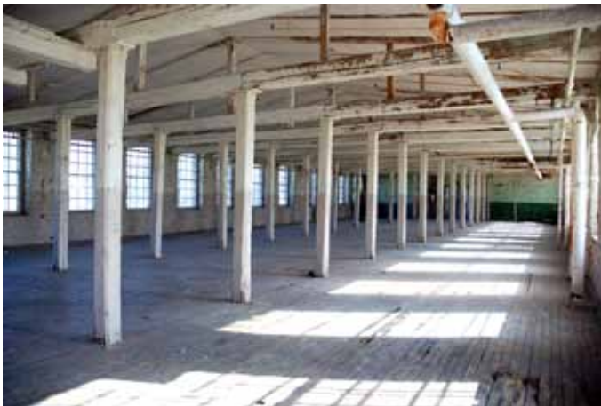
22. Bâtiment n° 14, à l'étage supérieur. Photo : SHHY, octobre 2011.
