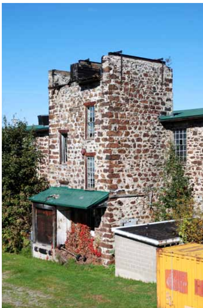
18. L'ancienne tour d'eau, qui s'adosse à la façade latérale gauche du bâtiment n° 1. Photo : Chantal Lefebvre, SHHY, octobre 2011.
