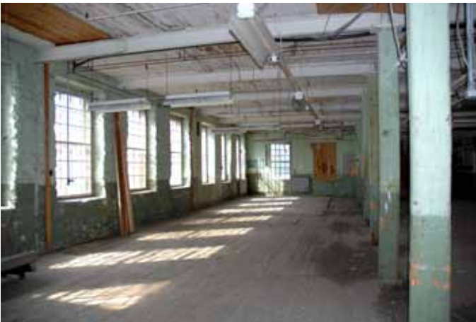
28. Travée délimitée par une série de colonnes de bois, visible dans le bâtiment n° 2, au rez-de-chaussée. Photo : SHHY, octobre 2011.
