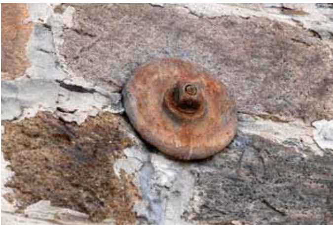
14. Tirant métallique visible sur la façade latérale droite et destiné à maintenir en place les murs du bâtiment afin qu'ils ne s'écartèlent pas.
