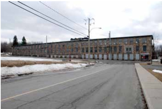
7. Façade latérale droite des bâtiments nos 1 et 14 vue à partir de la rue Saint-Joseph.
