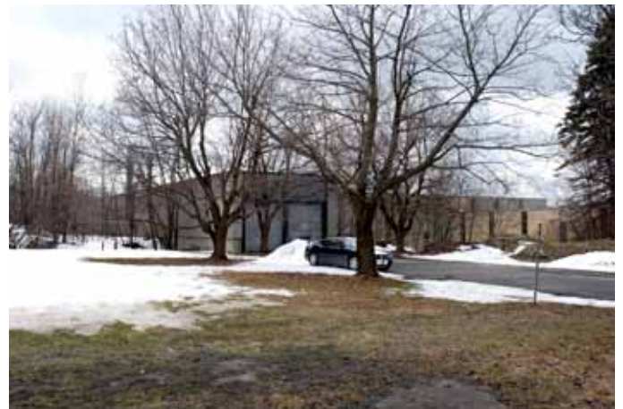
42. Les nouvelles installations inaugurées en 1966 sont toujours visibles à l'arrière de la structure d'origine.
