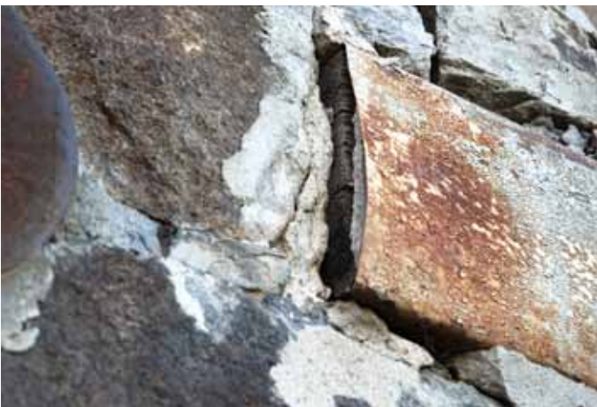
13. La plupart des fenêtres sont surmontées d'un linteau de bois recouvert d'un parement métallique destiné à le protéger des intempéries.
