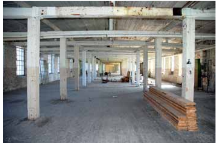
23. Travée centrale du bâtiment n° 1, à l'étage supérieur. Photo : SHHY, octobre 2011.
