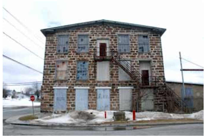
9. Façade arrière du bâtiment n° 14 à partir de la rue Saint-Jean.
