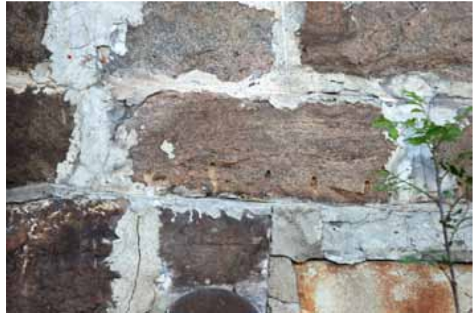
15. Certaines des pierres utilisées pour la maçonnerie des murs du bâtiment principal (nos 1 et 14) portent encore les traces des instruments utilisés pour tailler les blocs.
