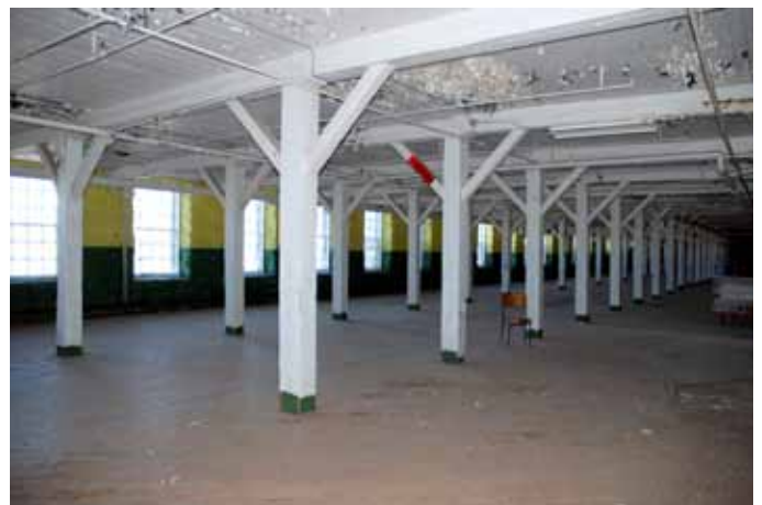
24. Colonnes et poutres de bois supportant la structure du bâtiment n° 1, au rez-de-chaussée. Photo : SHHY, octobre 2011.
