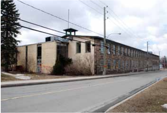
6. Façades principale et latérale droite du bâtiment n° 1. La structure longitudinale est accolée à la rue Stanley.
