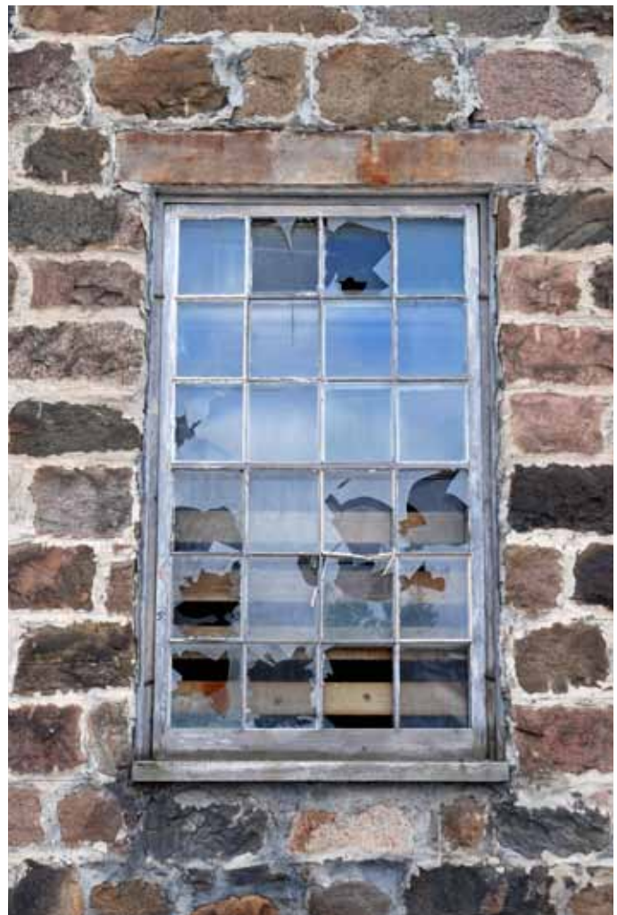
16. L'une des nombreuses fenêtres perçant la façade latérale droite du bâtiment industriel.
