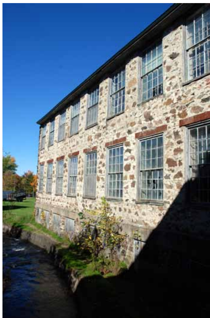
20. Façade latérale gauche du bâtiment n° 2 vue à partir du passage reliant les anciens bâtiments à la nouvelle partie. Photo : Chantal Lefebvre, SHHY, octobre 2011.
