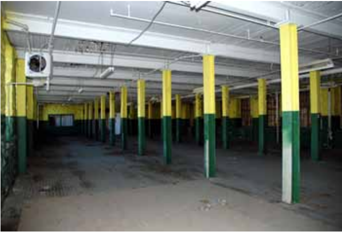
26. Poutres et colonnes métalliques en « I » supportant la structure du bâtiment n° 14, au rez-de-chaussée. Photo : SHHY, octobre 2011.
